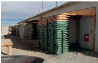
Fot. 1 i 2. Wykorzystanie worków do ochrony wejść do budynków.
