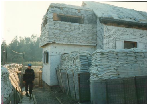
Fot. 81. Wykorzystanie worków do ochrony budynku.
